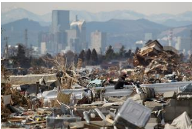
仙台市での道路整備作業の様子
