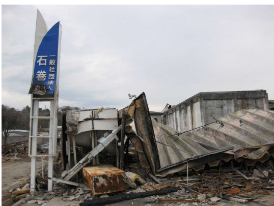
震災後の火災で焼失した宮城県石巻薬剤師会館
