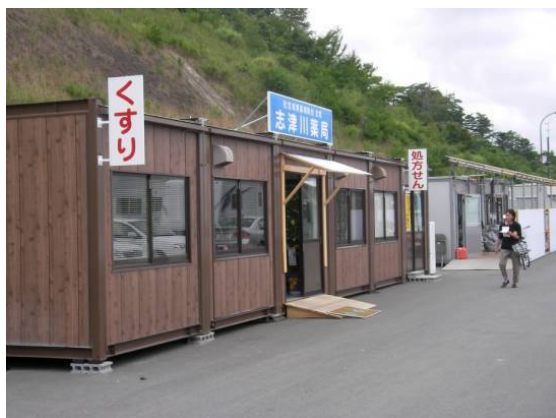
南三陸町ベイサイドアリーナ敷地内に開設した宮城県薬剤師会会営志津川薬局
